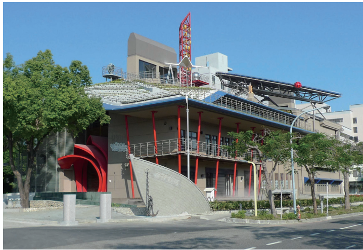
成功大學孫運璿綠建築科技大樓入選 全國首 2 例近零碳建築
